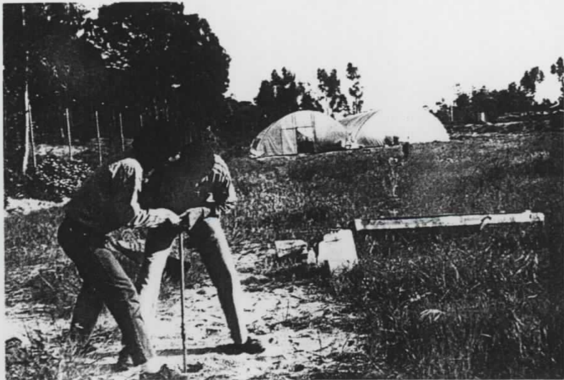
Foto 1: Apertura de huecos para la ubicación de las cápsulas.
