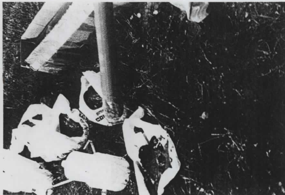
Foto 2: Preparación de la cápsula para su instalación.
